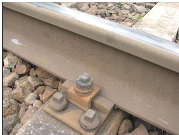
Detail železničního svršku, tuhé upevnění K
