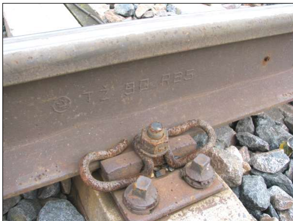
Detail železničního svršku, polopružné upevnění Ks
